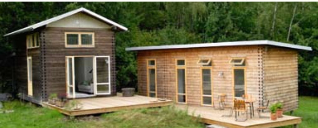
De inre knutarna utgör ändarna på innerstockarna. I utrymmet mellan inner- och ytterstock placeras isoleringen.
