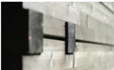
De inre knutarna utgör ändarna på innerstockarna. I utrymmet mellan inner- och ytterstock placeras isoleringen.
